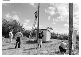
2021年10月10日「JARLレピータ(439.86MHz) 鹿児島県伊佐市大口川岩瀬」のサービスエリアが狭くなっていたため(ANTのSWRの数値が高く),新品ANTに取替作業を実施しました。稲刈り作業が進む田園を眺めながら、午前中に大口レピータ管理団体メンバー局長JR6JTO丁野、JF6JFA末原、中野さん、鹿児島市内局長JA6MST福吉、JA6VDM橋口、JG6MNG松木、日置市局長JA6NHN西の7名が集まって、お昼過ぎには作業が終わりました。現役時代の技でパンザマストに登って貰い、AHT準備やマストをロープで上げ下げ作業に力を合わせて頑張りました。準備備品(ロープ、滑車、3段ハシゴ、アナライザーなど)を各局が持ち合っての作業でした。作業に参加された皆さん無事に終えて、お疲れさまでした。
